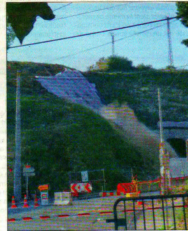
Avant - Après. Hier, au moment de la déflagration, le bec rocheux était protégé d'un filet de sécurité pour contenir les projections accidentelles. (Photos G. C.)
