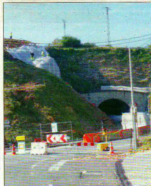
Avant - Après. Hier, au moment de la déflagration, le bec rocheux était protégé d'un filet de sécurité pour contenir les projections accidentelles. (Photos G. C.)
